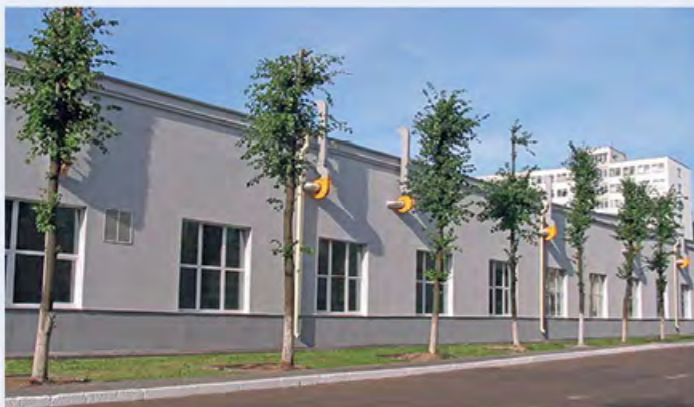
Первая производственная площадка. Новый сборочный цех стартеров. 2008 г.
