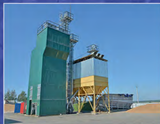
В хозяйстве построен сушильный комплекс.
