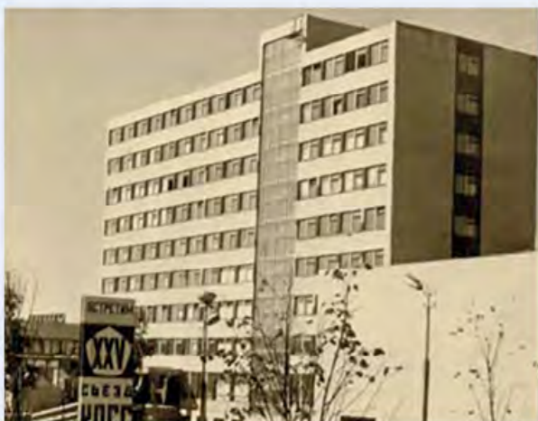
Новый инженерный корпус. 1974 г.
