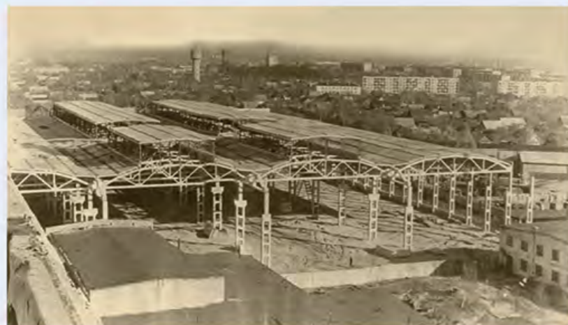
Строительство производственного корпуса на 18 тыс. м 2 . 1974 г.
