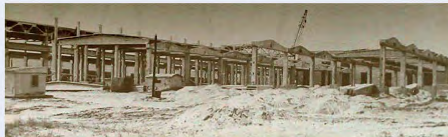
На строительстве главного производственного корпуса. 1967 г.
