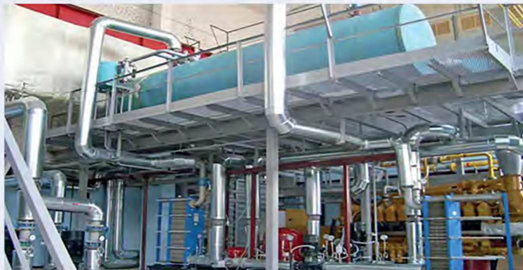
В целях обеспечения энергетической безопасности на предприятии функционирует когенерационный комплекс установленной мощностью 5,0 МВт
